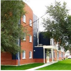
Exemple de réalisation à Ville Sainte-Catherine
